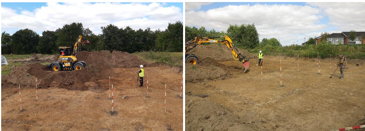
Arbejdsfotos af to udgravningssituationer: Muldafrømning og detektorafsøgning af fremkomne anlæg. Langhusets (K1's) seks tagstolpehuller samt to skillevægsstolpehuller er markeret med landmålerstokke.
