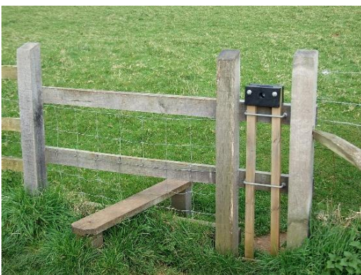
Figur 146: Stente, her i en meget enkel udformning som "trinbræt", dog med hundepassage til højre, hvilket nok er et nymodens påhit. Stenten kan udformes ret forskelligt, og vil uanset udformning afstedkomme nedgravning af stolper ved siden af hegnene på begge sider.
